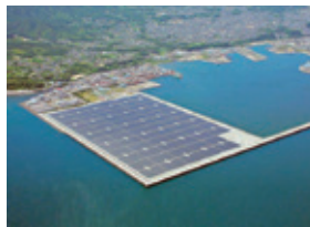
日本最大級の発電能力(70MW)をもつ鹿児島七ツ島メガソーラー発電所 写真出典：株式会社 IHI
