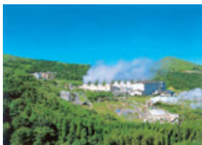
八丁原地熱発電所 写真出典：経済産業省
