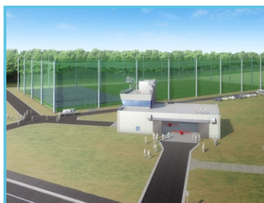
緩衝ネット付飛行場・滑走路附属格納庫
