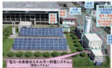
再生可能エネルギーを主力電源化して供給変動が大きい場合にも、電力需給を火力なしで高精度で調整できる水素・超電導電力貯蔵装置等を利用した先進的なエネルギー貯蔵技術の基盤を構築し、脱炭素化に貢献する。
