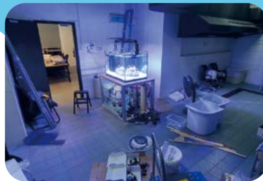
Center of Garage Malaysia での水槽設置作業の様子
